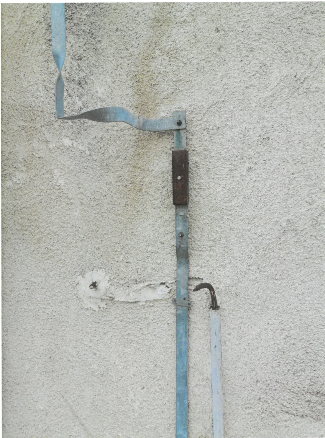
Element coborare instalatie paratraznet: dispozitiv de deconectare manufacturat, neprotejat , cu elemente ruginite conectate cu suruburi.
